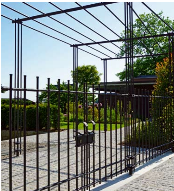
Schmiedelack mit hohem Glimmeranteil gibt dem feuerverzinkten Schmiedeeisen aus der Meisterwerkstatt von Oskar Hafen einen edlen Look.
